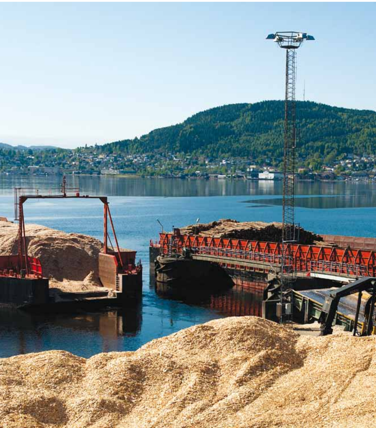
Lierterminalen på Lierstranda håndterer årlig 800 000 kubikkmeter med tømmer og er den største flis- og tømmerterminalen i landet.
