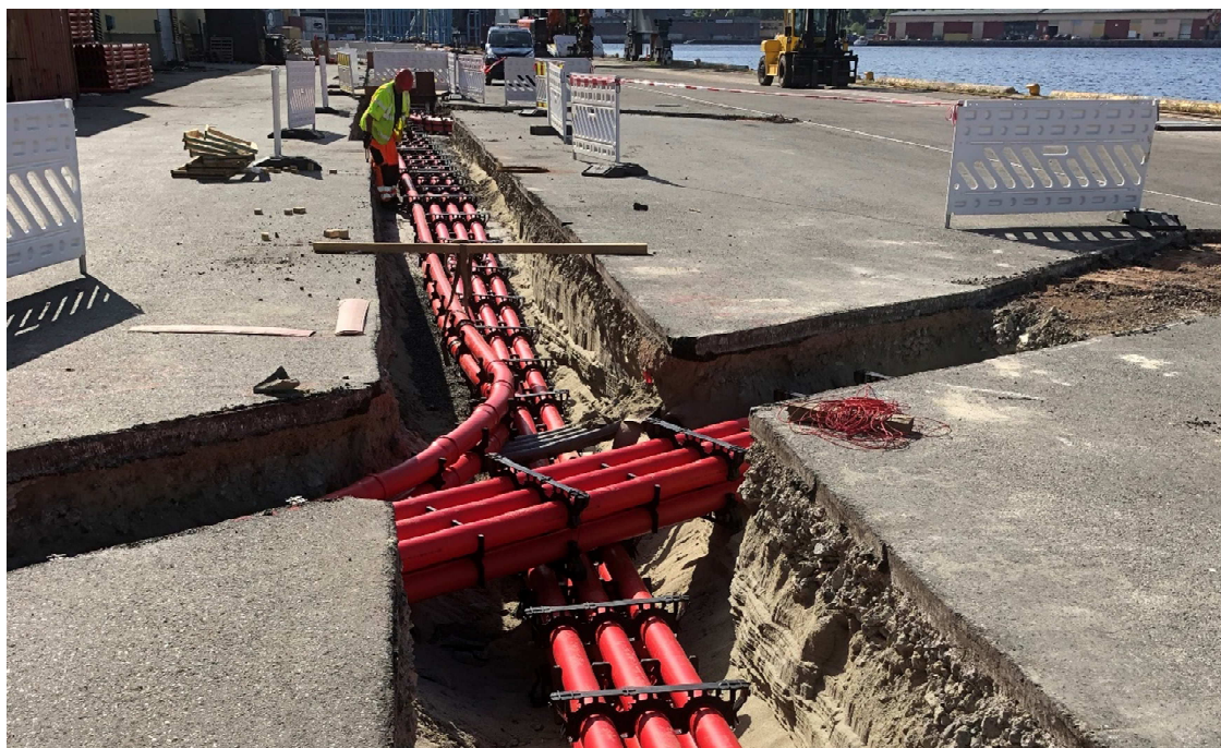
Trekkerør legges på Holmen-Syd
