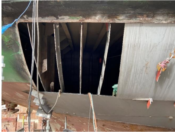
Utskifting av stål langs vannlinjen / ballasttank akterut
